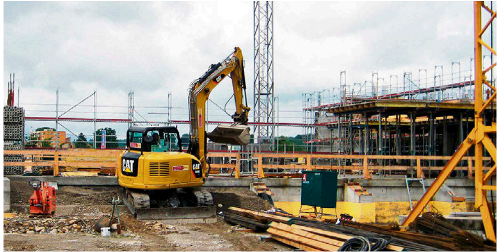
Eine Baustelle in der Region Luzern.
